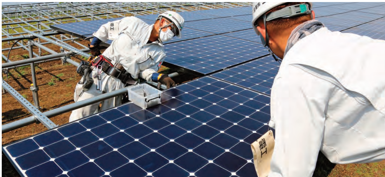
Chantier d'installation de panneaux solaires Sunpower chez Sasyunkan co, Kumamoto, Japon.
