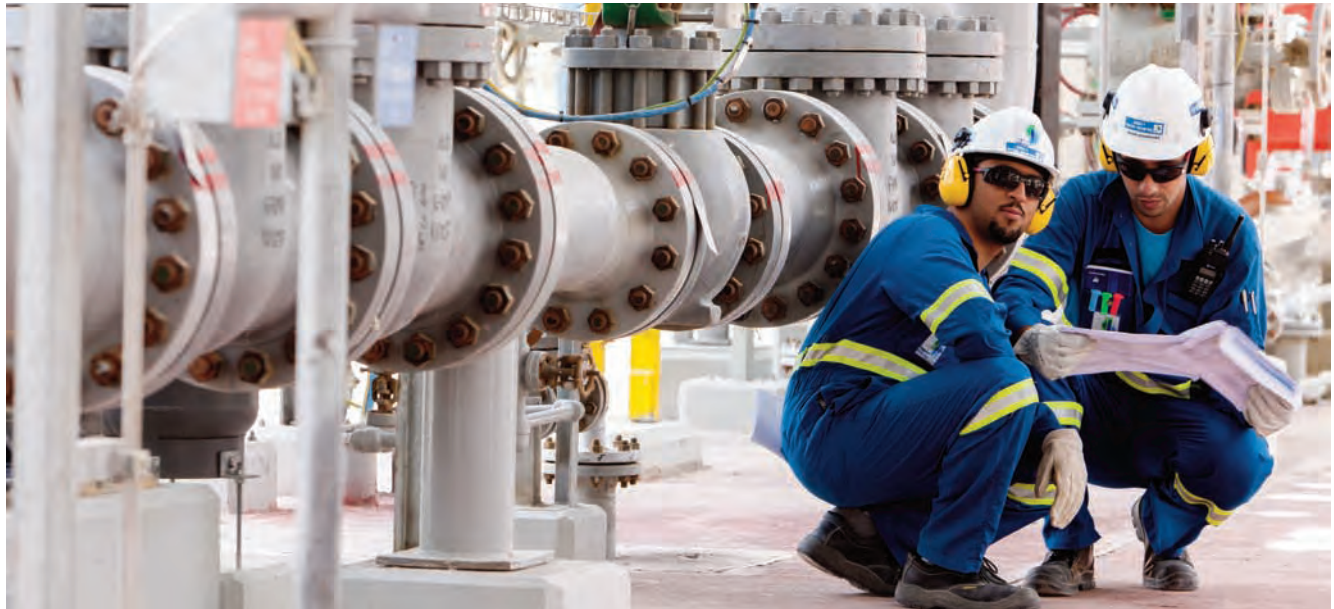
Opérateurs extérieurs sur la raffinerie Satorp à Jubail, Arabie Saoudite
